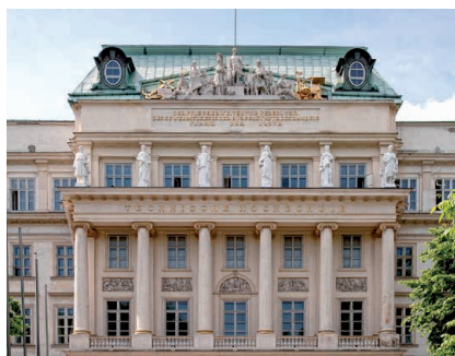
TECHNISCHE UNIVERSITÄT WIEN, HAUPTGEBÄUDE © TU Wien
